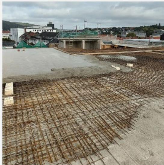
Betonage der neuen Decke über dem 4.OG.
