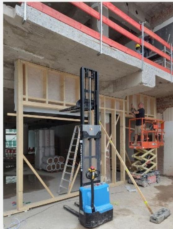
Montage der neuen Holzwände: Die Wände für das 4. und 5. OG werden als Modulfertigteile geliefert. Hingegen werden die Wände im Innenhof auf Grund der auskragenden Bestandsbetondecke Vorort aus vorgefertigten Einzelteilen erstellt.
