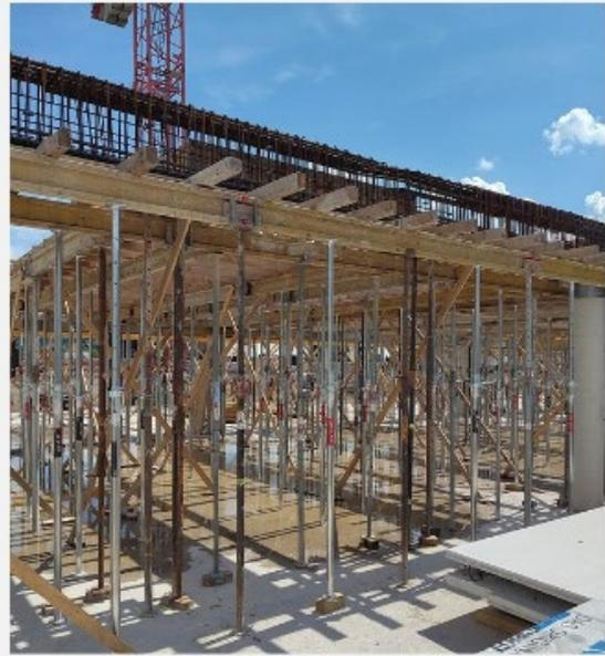
Sicherung der Bestandsbrüstung im 4.OG mit dem neu errichteten Betontragwerk (li.) und Errichtung des 4.OG in Betonkonstruktion.
